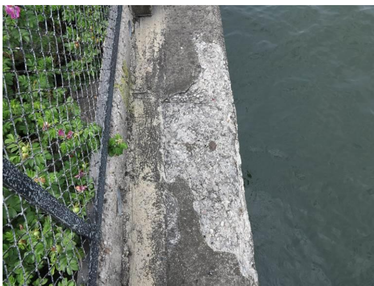
Zdjęcie 2 Uszkodzenia powierzchniowe betonu, lokalnie ubytki na koronie oczepu
