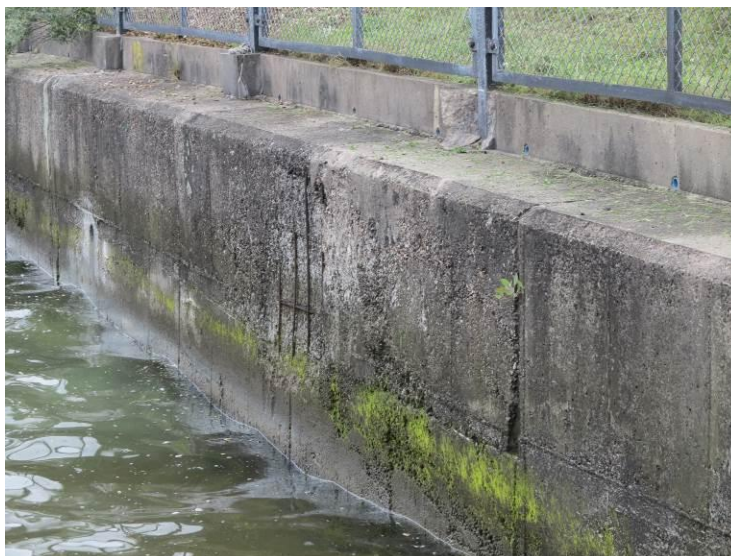
Zdjęcie 1 Uszkodzenia powierzchniowe betonu, lokalnie widoczne zbrojenie
